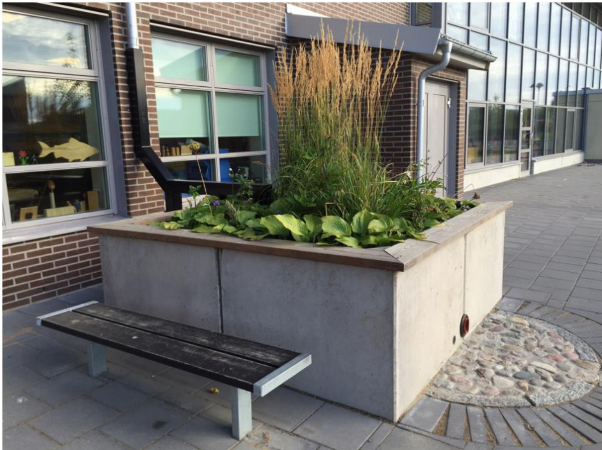
Figur 17. Exempel på hur en upphöjd regnbädd kan utformas (Bara mineraler AB, uå).
